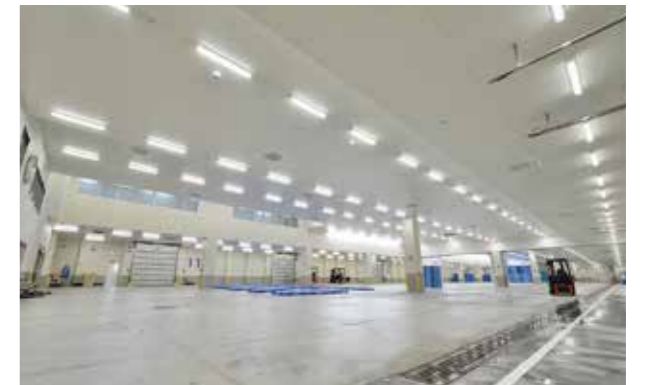
施設内は空調設備を完備。菌の繁殖を防ぐため、床は緩く傾斜をつけ水捌けの良い素材を使用
