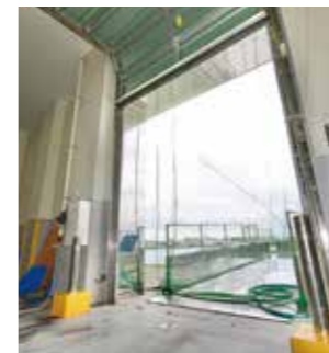
水産物の搬入後はシャッターを閉め、外部からの粉塵混入や害獣の侵入を防いでいる
